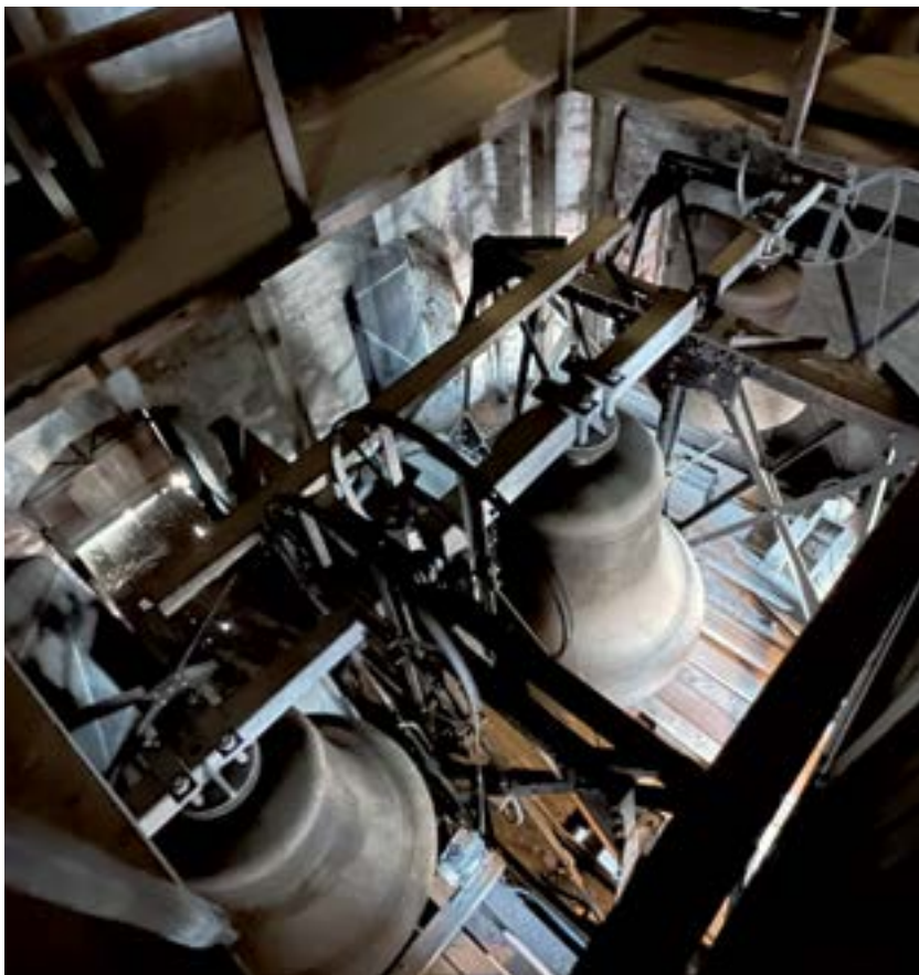
En solid klokkestol i jern må til for å holde de tre tunge kirkeklokker på plass når de ringer.
